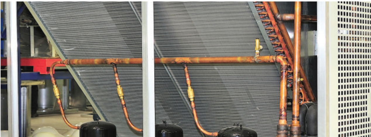
Konvansiyonel tip bakır boru/alüminyum kanatlı kondanser sistemi/ Conventional type copper tubes/aluminum fins condenser system
